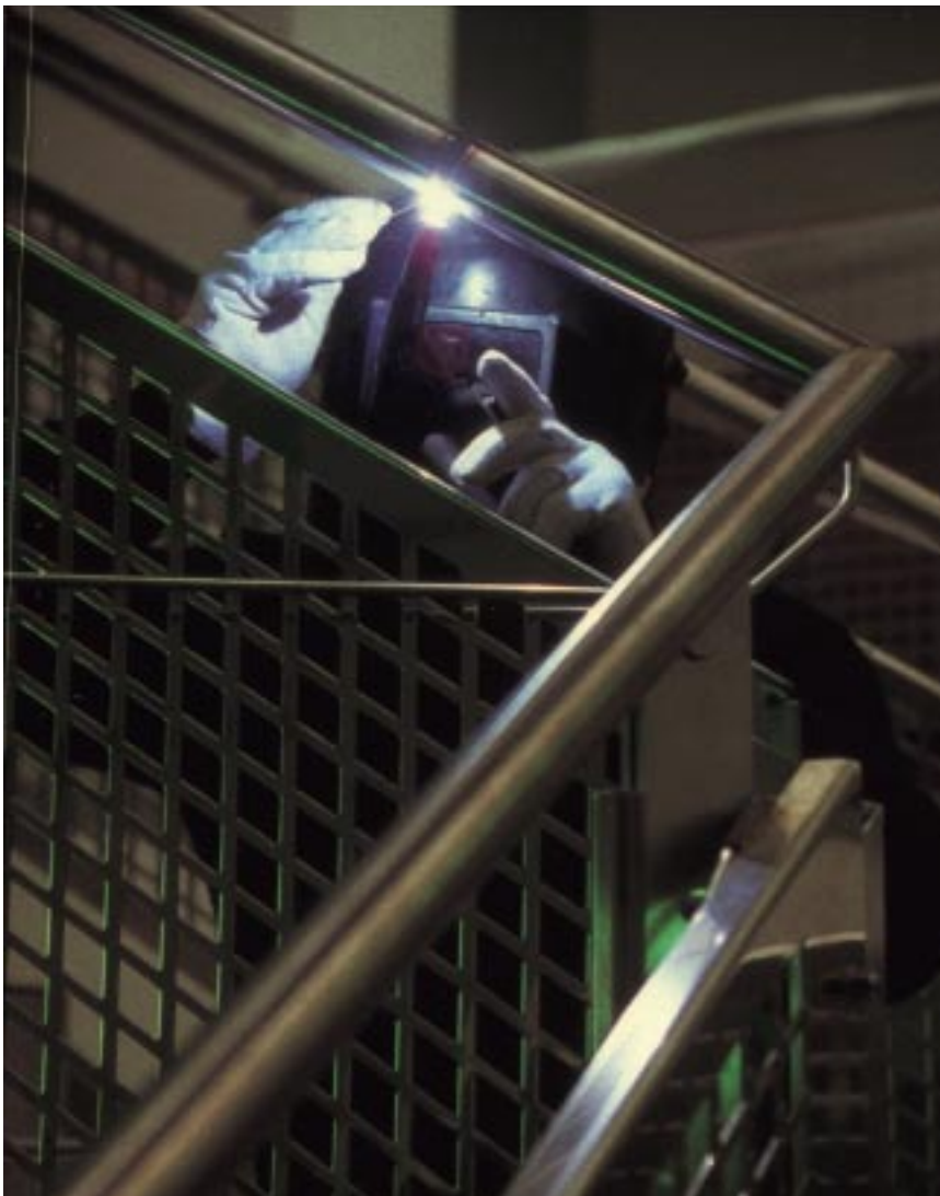
Bild 14: WIG-Schweißen auf der Baustelle
